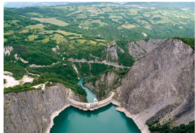
Le barrage de Monteynard-Avignonet. On distingue le belvédère en forme de V à gauche sur la photo. Le site a été aménagé par EDF avec des panneaux explicatifs et des tables de pique-nique
